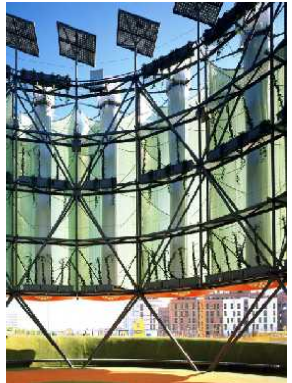
Σχήμα 80: Η δομή του Air Tree. Σκελετός - Φυτά - PDEC towers.
